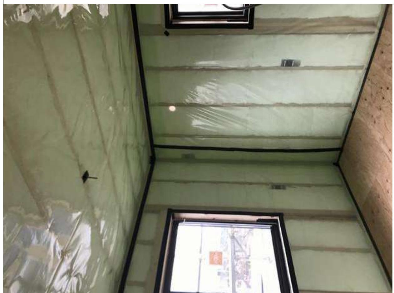
2-3□断熱材は隙間・欠損・施工不良がないように施工する。 断熱材は配管部分に隙間ができないように気を付ける。
