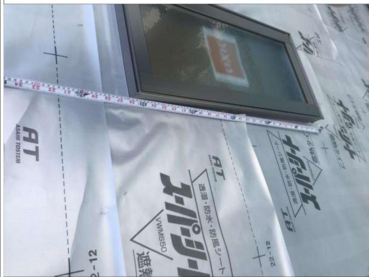
3-3□防水テープの幅は、適切な寸法のものを使用する。
