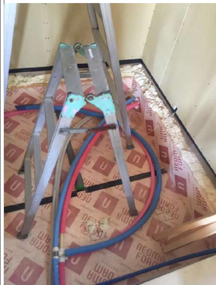
2-5□防湿層（気密シート）は幅広の長尺シートを用い、連続させ、隙間の出ない
