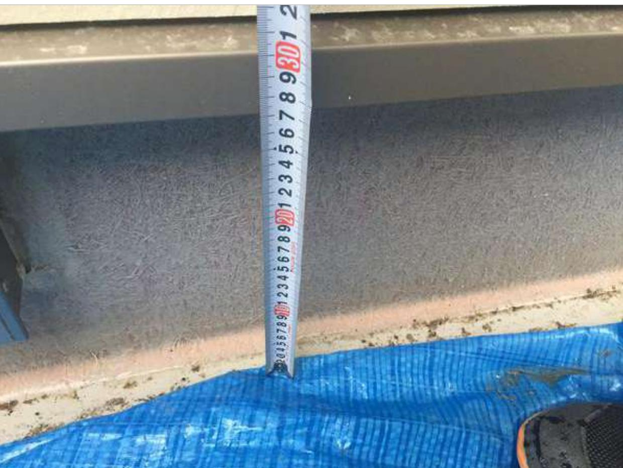
3-14 バレコニー防水層の立上り高さは、外部開口部の下端で120mm以上、
