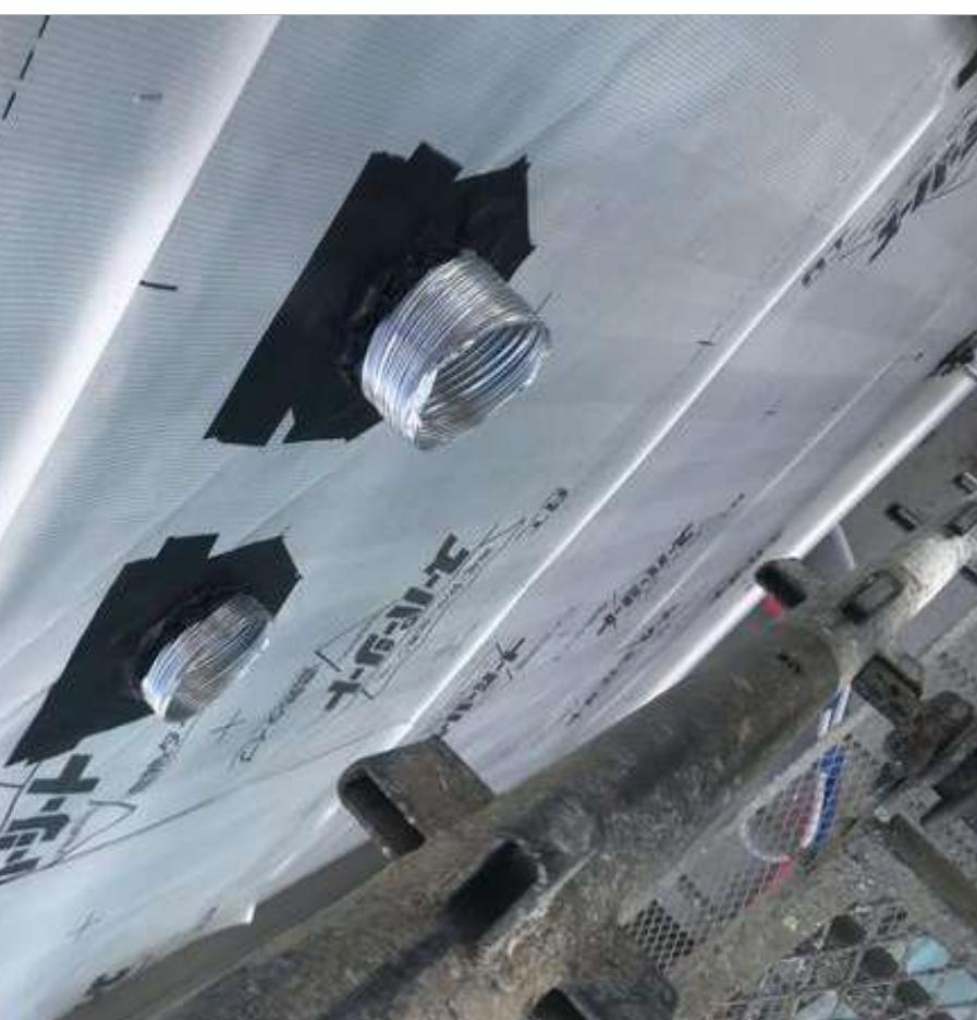
3-11 配管、配線が2本以上貫通する場合は、さや管を使用し、防水措置を適切に処理する。
