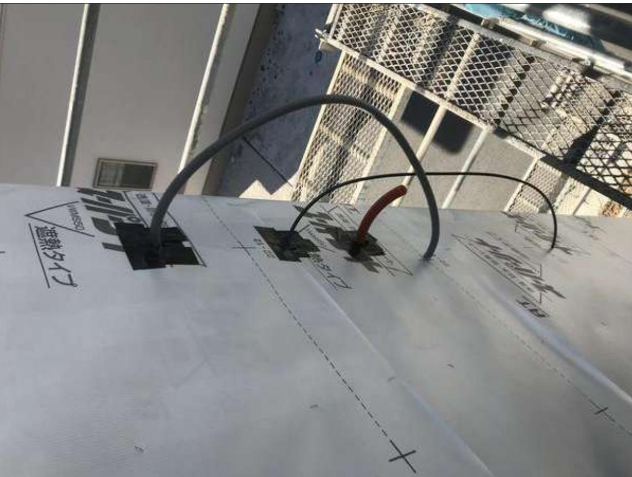
3-14 バルコニー防水層の立上り高さは、外部開口部の下端で120mm以上、それ以外の部分で250mm以上とする。(1/2)
